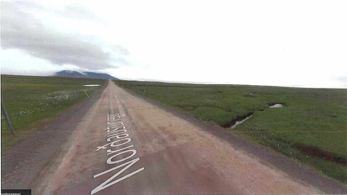
Mynd 3. Gunnlaugsá við fyrirhugað vegstæði
